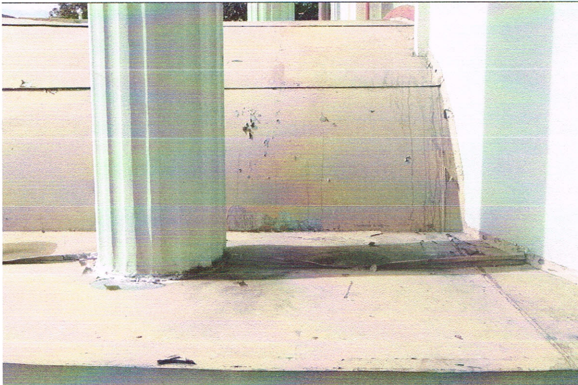
5.fotoattēls. Skārda seguma bojājumi
